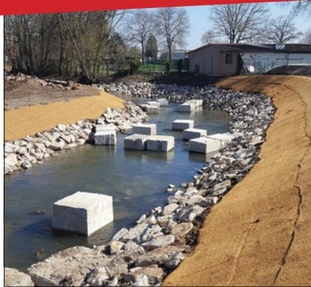
Après un nettoyage des berges, celles-ci ont été reprofilées, terrassées et consolidées à l'aide d'enrochements et de fascines (fagots) de saule. De gros blocs de béton ont été positionnés sur la largeur du bras. Il s'agit d'**îlots directionnels** qui aident les poissons à remonter la Zorn. La création de ces **zones de turbulence et d'accélération permet l'orientation** des poissons. Des zones de repos et de reproduction ont également été mises en place. En parallèle, l'installation
