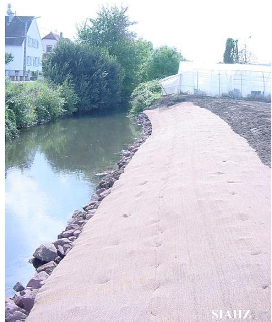
Restauration de berges et pose de géotextile à Dettwiller (SIA du bassin de la Haute Zorn)
