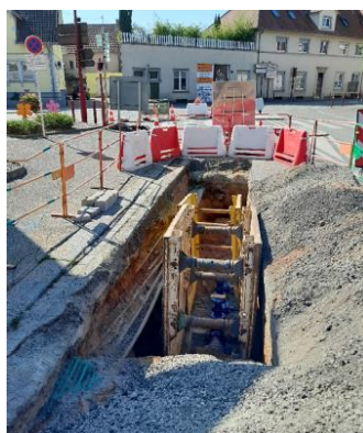
Geudertheim- Rue des Potagers Rénovation du réseau de distribution et des branchements particuliers
