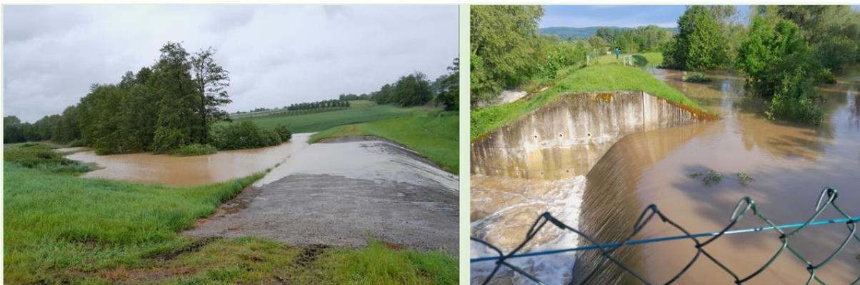
Figure 2: Les ouvrages écrêteurs de crue à Dettwiller et à Steinbourg ont été mis en charge
