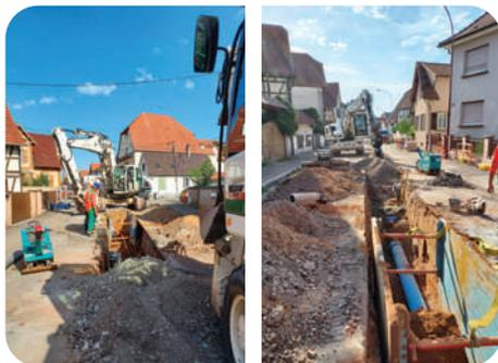
**Rue de la Gare** : travaux de renforcement du réseau d'eau potable et reprise des branchements particuliers.
