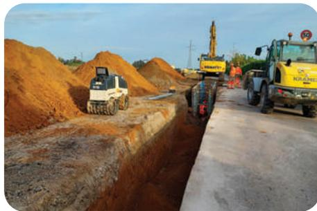
**Rue du Ried** : renforcement de la conduite d'eau dans le cadre de la sécurisation de la ressource en eau potable.
