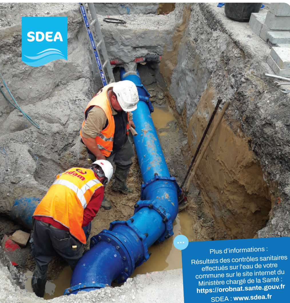
Pose d'une conduite d'interconnexion
