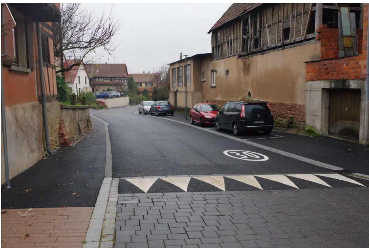
Rue Creuse à Weyersheim après réfection
