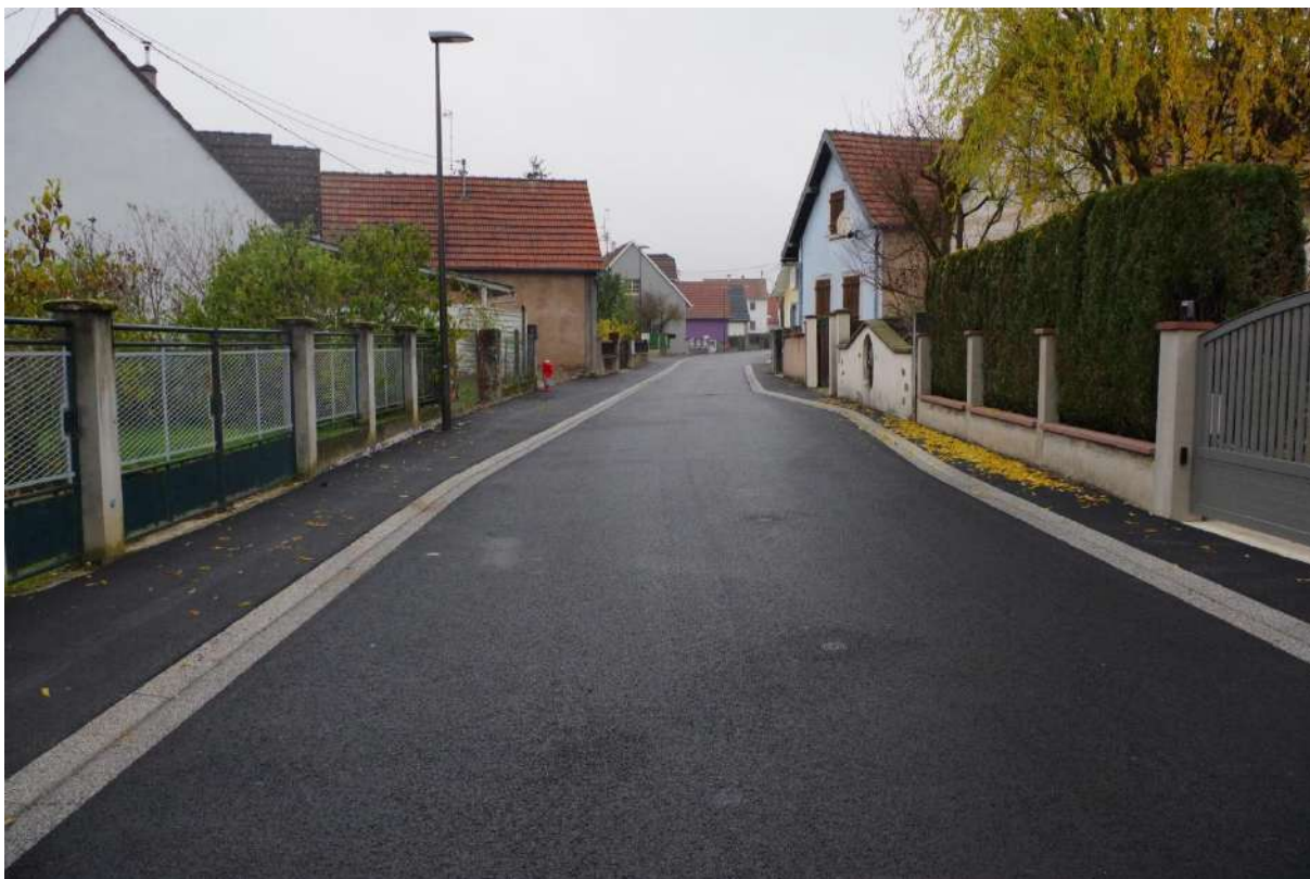
Rue du Stade à Gries après réfection
